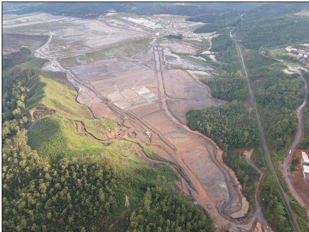
Foto 2: Vista do reservatório da barragem de Germano de montante para jusante.
