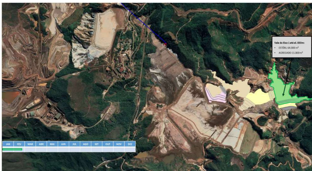
Figura 18 – Descaracterização dos Dique de Sela – Ano 2025
