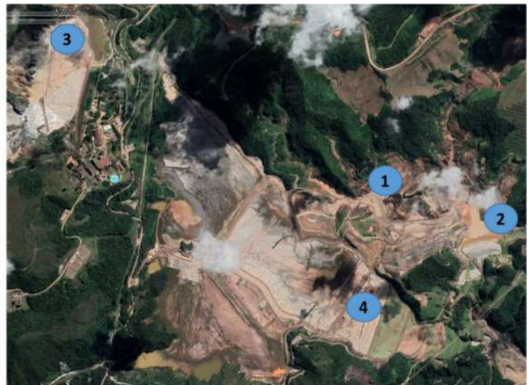
Figura 09 – Obras executadas – continuidade da recuperação
