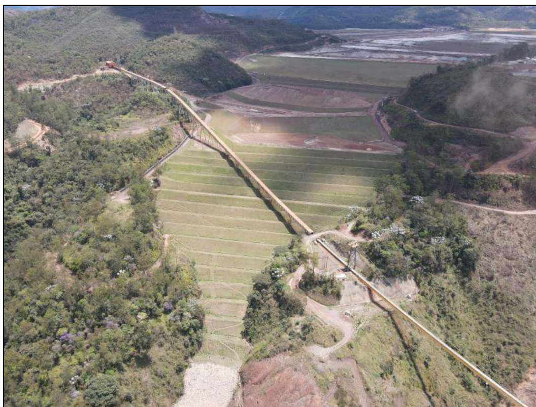
Foto 1: Vista dos taludes da Barragem de Germano.
