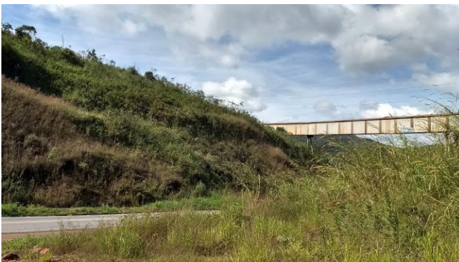
Foto 05 – Vista do imóvel.
