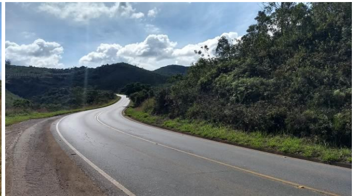
Foto 04 – Vista do imóvel.
