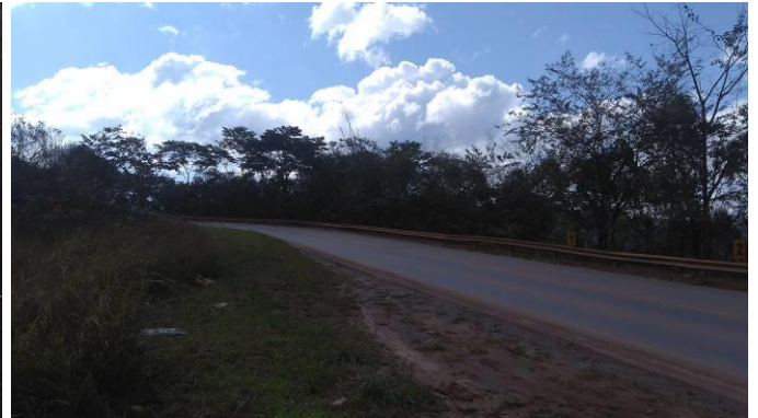
Foto 02 – Vista do imóvel.
