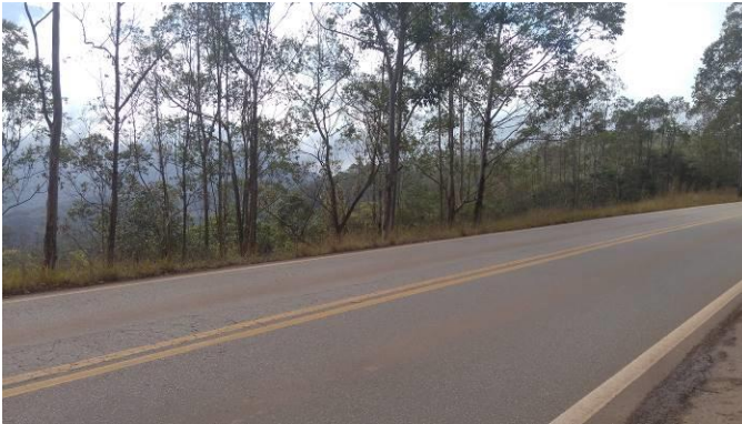
Foto 01 – Vista do imóvel.
