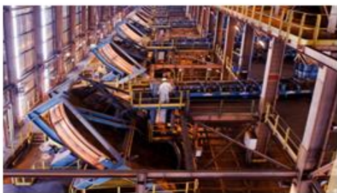
3 - Usina de Pelotização, Complexo de Ubu, Anchieta/ES
