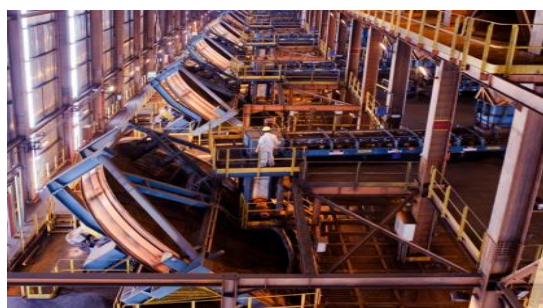
3 - Usina de Pelotização, Complexo de Ubu, Anchieta/ES
